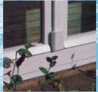
*Huellas de humedad y bacterias en una ventana de madera de una vivienda situada al lado del mar. Al contrario que la madera, el PVC no se ve afectado por la corrosión, el salitre, los mohos ni las bacterias.*
